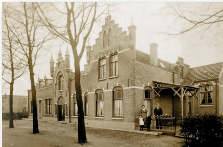
Het gezin Anspach-Boon. Het linker deel was na de verbouwing een zelfstandige woning. Achter de linker topgevel was het postagentschap gevestigd terwijl het rechter deel helemaal in gebruik was als woonhuis voor het gezin Anspach.
